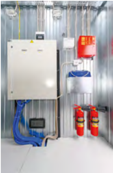
▲ Шкаф автоматического ввода резерва (АВР) монтируется на стене контейнера
